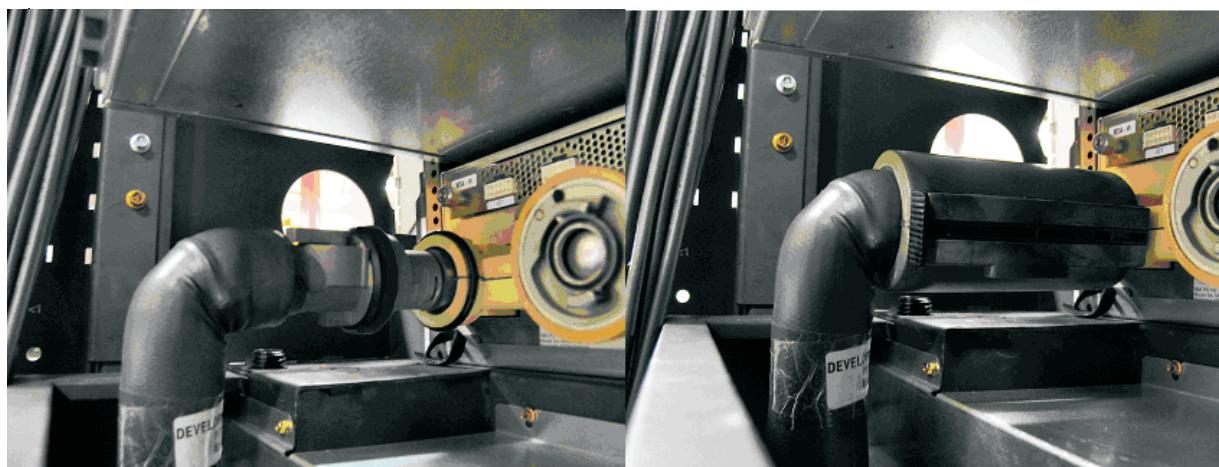
Figure 144. Raccord à débranchement rapide sans isolant (gauche) et avec isolant (droite)
