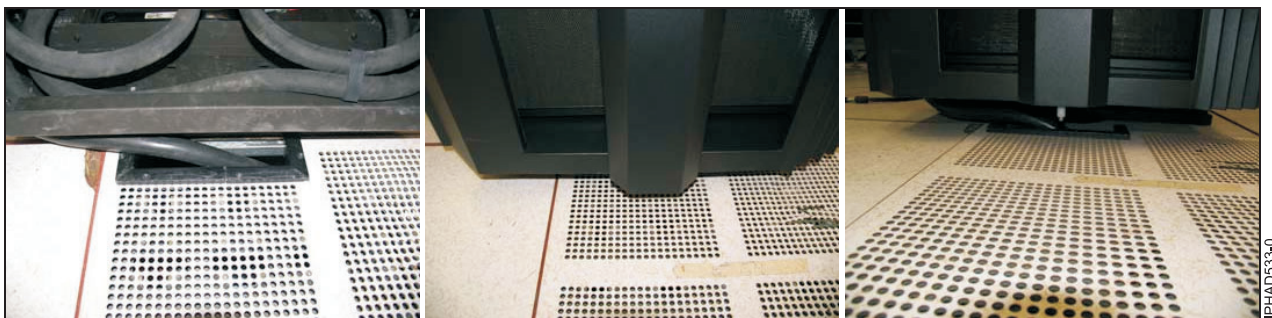
Figure 116. Images de découpe de dalle avant
